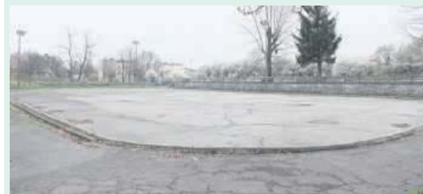
Aby zwiększyć zainteresowanie przetargiem wśród wykonawców, gmina Strzelin zdecydowała o podziale prac na strzeleńskim lodowisku na kilka etapów
