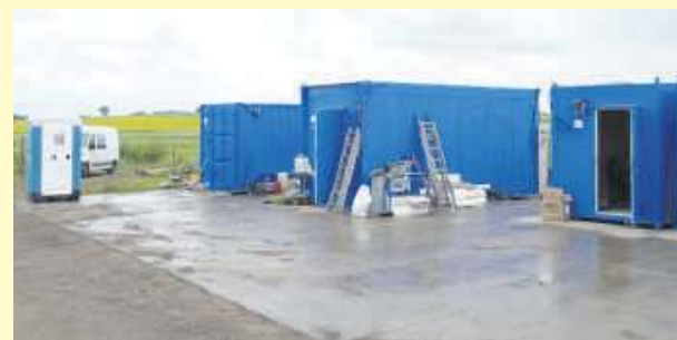
W ubiegłym tygodniu ruszył ostatni etap remontu zbiornika zalewowego w Przewornie. Ustawione zostało już zaplecze socjalne
