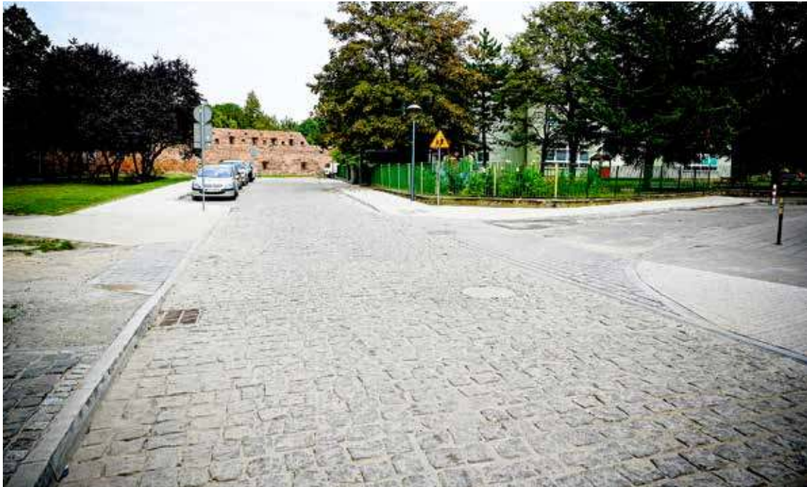
Tak wygląda fragment ul. Spichrzowej po remoncie
