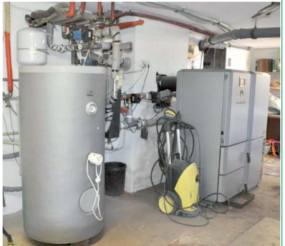
Dzięki dofinansowaniu pozyskanemu z Programu Czyste Powietrze Iwona Dzikowska z Kępy Choteckiej wymieniła piec na węgiel i drzewo na nowoczesny piec na pellet. Dzięki temu problemy z rozpalaniem pieca każdego dnia znikły. Teraz Pani Iwona do kotłowni schodzi z przyjemnością
