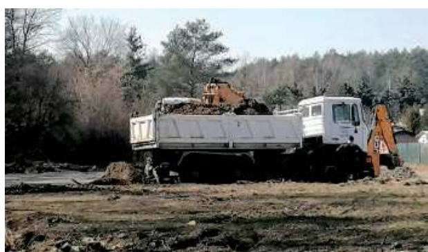
Trwają roboty ziemne związane z profilowaniem i zagęszczeniem podłoża. Na części obszaru już wykonywana jest nawierzchnia z kruszywa łamanego
