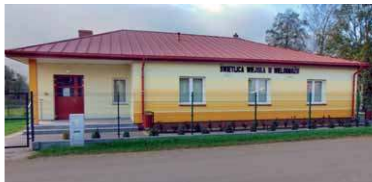
W ramach środków zewnętrznych i budżetowych przebudowaliśmy 17 świetlic gminnych, w 2020 r. w Karwaczu, Wielodrożu i Osówcu Szlacheckim
