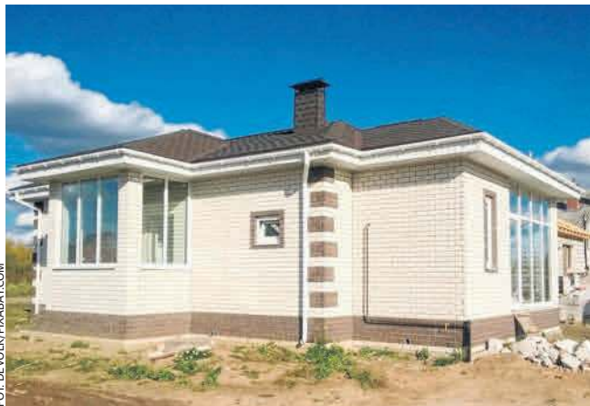
Budowa domu jest inwestycją na lata, warto zatem zadbać o to, by nasz budynek mógł nam służyć długo
