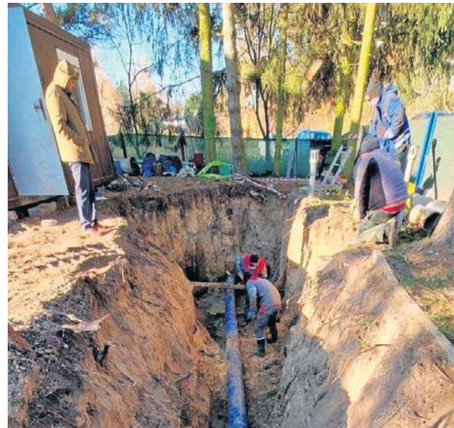
W Zwoleniu prowadzona jest rozbudowa i modernizacja miejskiej oczyszczalni ścieków.
