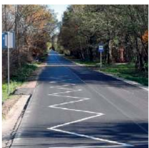
Remont drogi powiatowej Łopiennik-Żulin-Rejowiec
