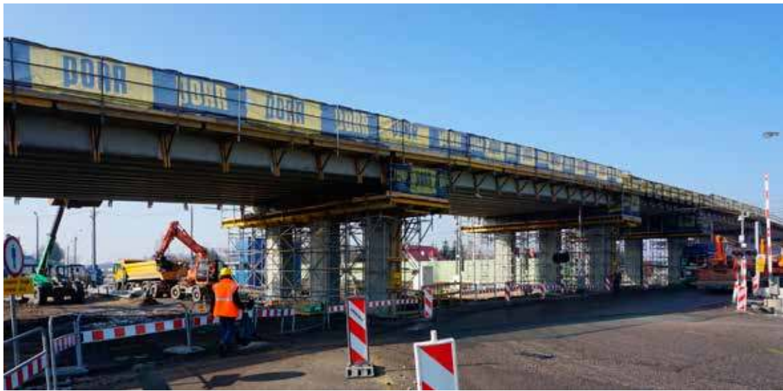
Wiadukt ma być gotowy jeszcze w tym roku.
