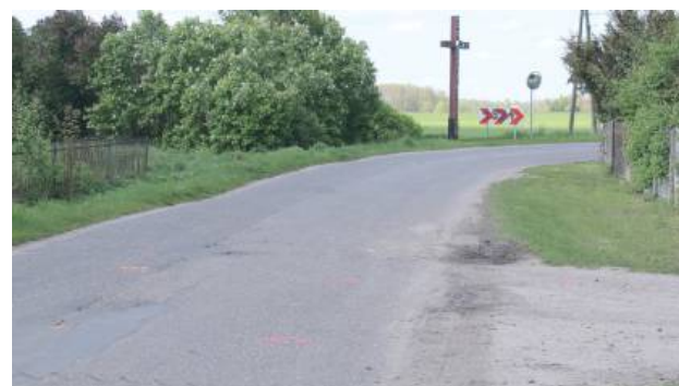
W Mościskach rozpoczęto remont drogi powiatowej nr 1203L
