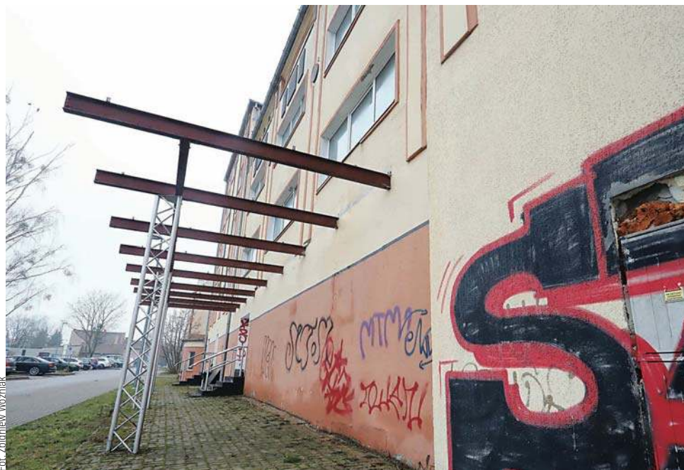
Komin najprawdopodobniej czeka wyburzenie. Co powstanie w tym miejscu?
