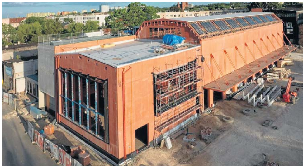
Cały projekt realizowany jest w poprzemysłowych przestrzeniach byłej Dąbrowskiej Fabryki Obrabiarek Defum
