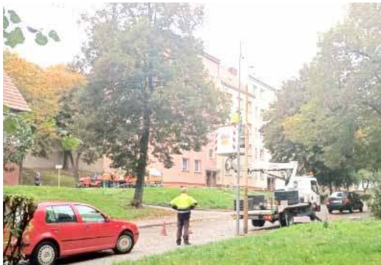
Wymiana skorodowanego słupa na Płatnerzy
