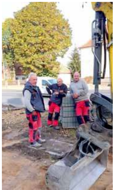
Od ubiegłego tygodnia trwają prace na wspomnianym odcinku chodnika
