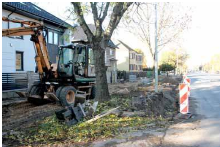
Plac budowy został przekazany 12 października. Remont ma się zakończyć 12 grudnia
