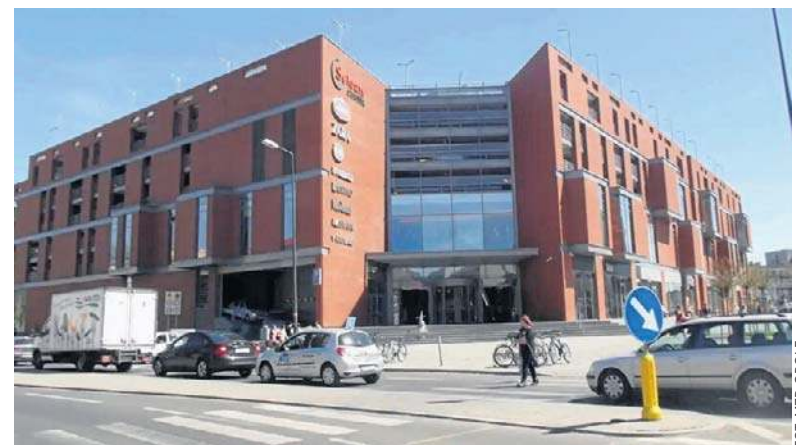
Prace potrwać do połowy grudnia.
