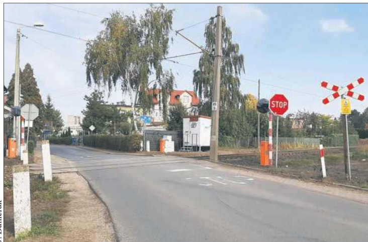
Trwa przebudowa przejazdu kolejowego na ulicy Rzecznej
