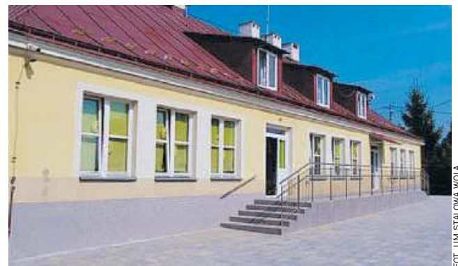
„Piątka” będzie miała nowy dach
