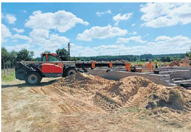
W Karzcinie ruszyła budowa mieszkań wspomaganych
