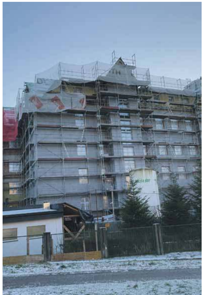
Budżet uchwalony, będą pieniądze na dokończenie budowy szpitala.
