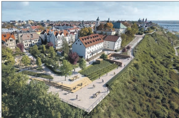
Będzie przebudowany kolejny odcinek alejek na płockiej skarpie
