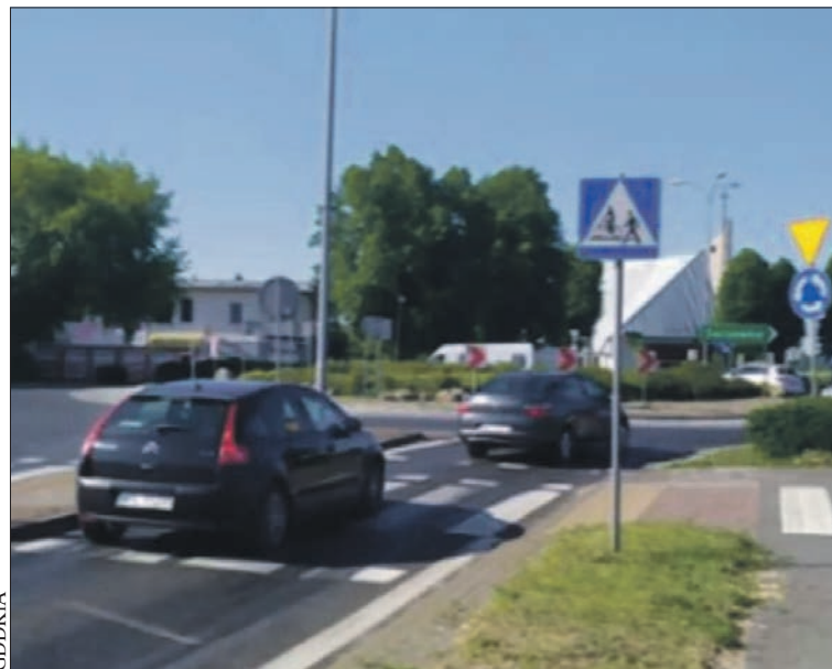
GDDKiA szuka wykonawcy obwodnicy Łącka i rozbudowy DK60
