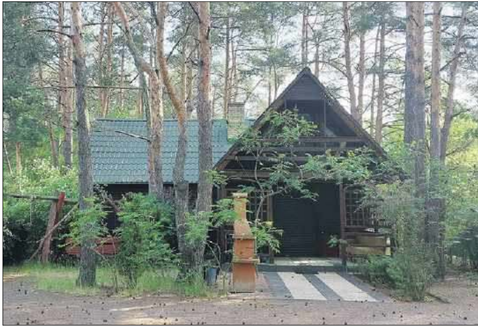
Wpływu sezonu jesienno-zimowego na wolnostojące budynki działkowe nie należy lekceważyć, zwłaszcza pod względem ochrony instalacji wodnej przed mrozami
