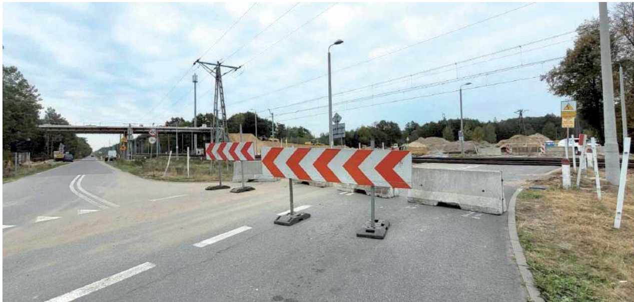
Zamknięcie międzyrzeckiego przejazdu kolejowego spowodowało duże komplikacje w ruchu drogowym
