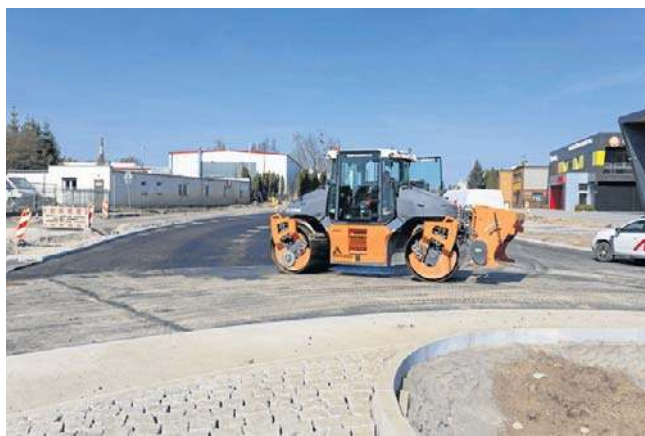
Budowa miejskiego ringu w rejonie ulicy Słonecznej w Słupsku
