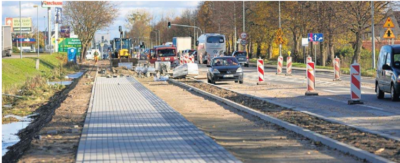
Ulica Słupska w Bolesławicach w trakcie remontu
