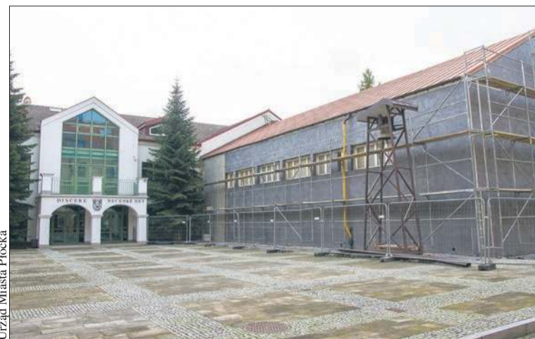
Trwa termomodernizacja sali gimnastycznej w Małachowiance
