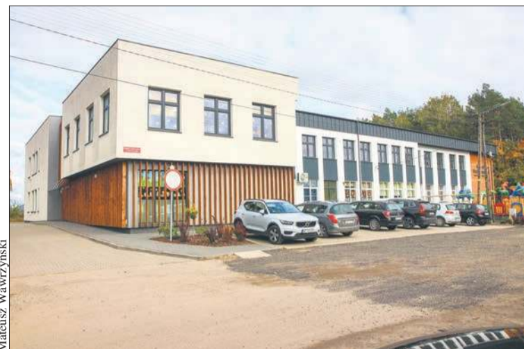
Tak prezentuje się budynek szkoły po modernizacji
