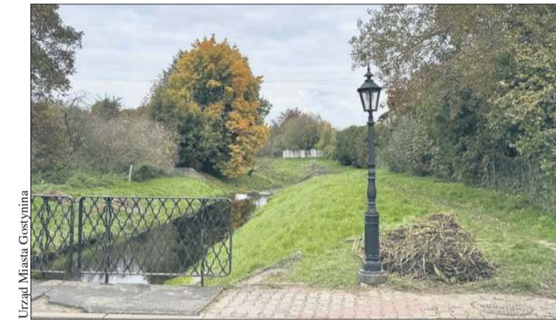
Rozpoczynają się prace na korycie rzeki Skrzy Lewej
