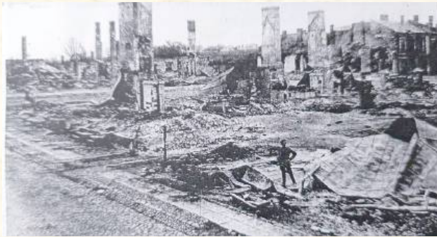
Zniszczenia w Nowej Aleksandrii przy ul. Lubelskiej (1915 r.)
