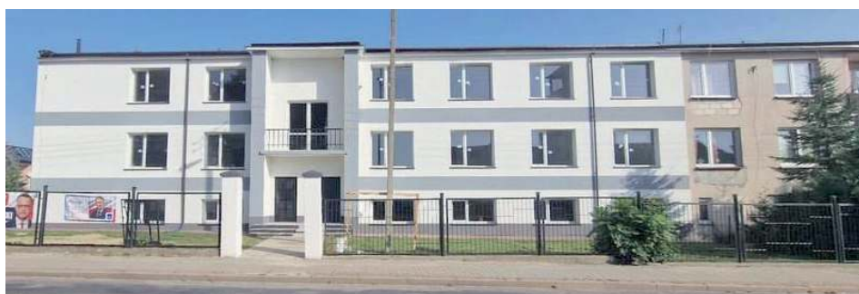
W budynku po byłym internacie w Turobinie będzie teraz dom kultury i biblioteka
