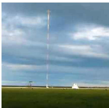
Rysunek 18. Były maszt Omega Tower Woodside o wysokości 432 m, kadr z filmu na stronie https://youtu.be/S_T7hd0oXUE . Zwróć uwagę na betonowy budynek spiralny po prawej stronie
