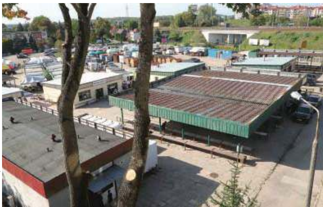
Remontowana jest wiat nr 2
