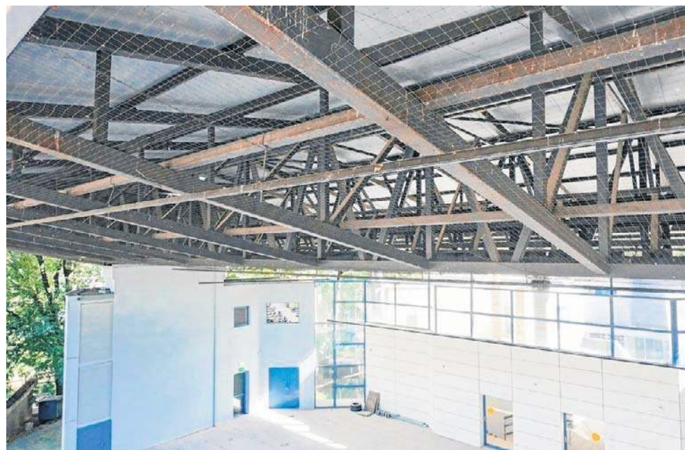
Zakłady Zastal wyprodukowały m.in. konstrukcję dachu zielonogórskiego amfiteatru
