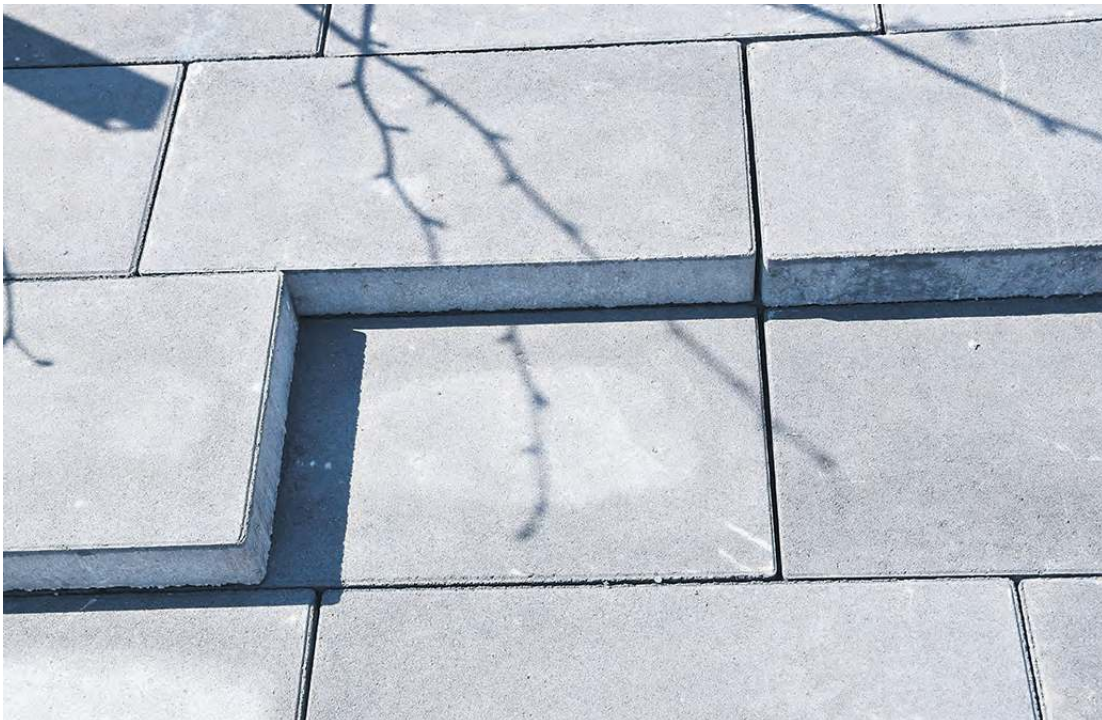
Płytek, szczególnie tych o większych wymiarach, z powodzeniem można użyć jako stopni schodowych.
