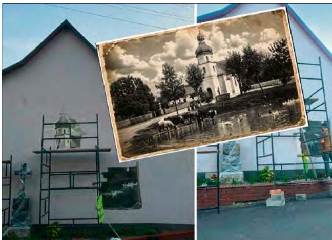
Rozpoczęły się prace nad murem, który powstaje na pamiątkę zakończenia renowacji kaplicy w Oleszce oraz obchodów 150-lecia jej budowy.
