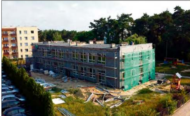
Przedszkole nr 8 jest jednym z obiektów objętych tegoroczną termomodernizacją.
