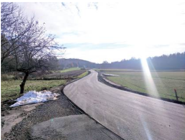
Nowy asfalt na Słowiczej już gotowy
