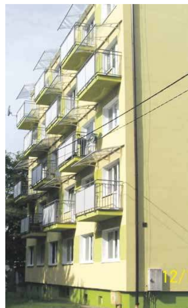
Prace remontowe przy ul. Wrocławskiej 98
