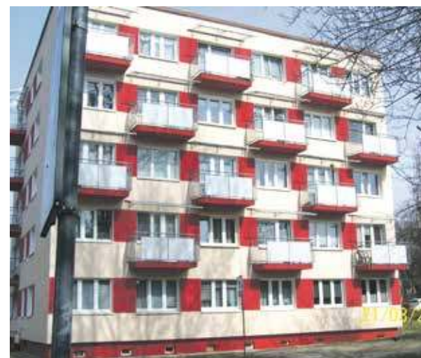
Prace remontowe przy ul. Wrocławskiej 96
