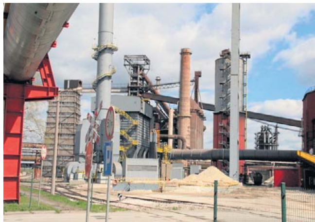
W dąbrowskim oddziale ArcelorMittal Poland doszło do śmiertelnego wypadku
