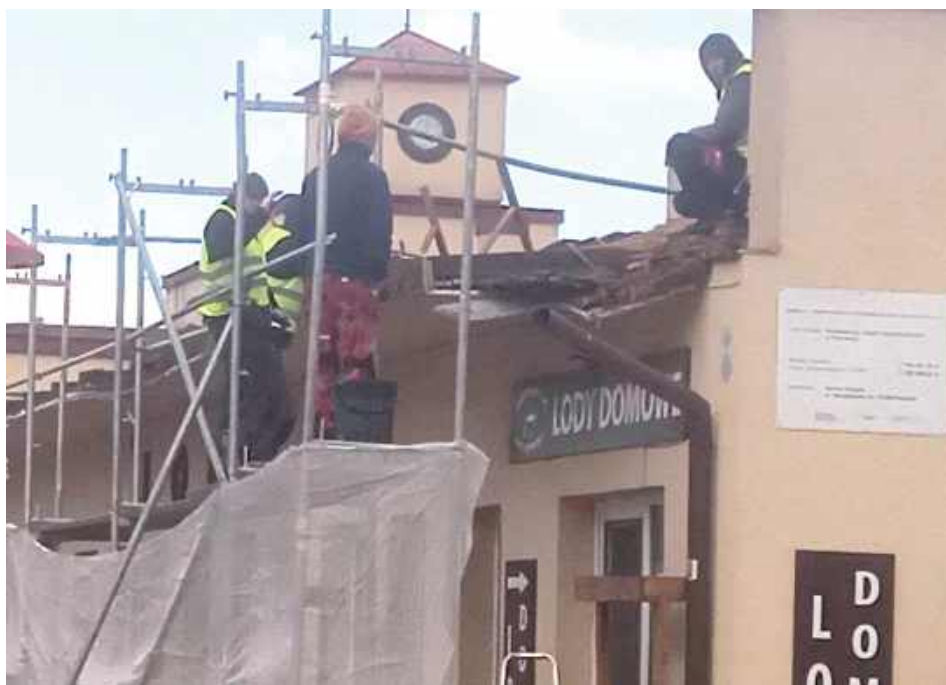
GR Pierwsze prace ruszyły przed Wielkanocą
