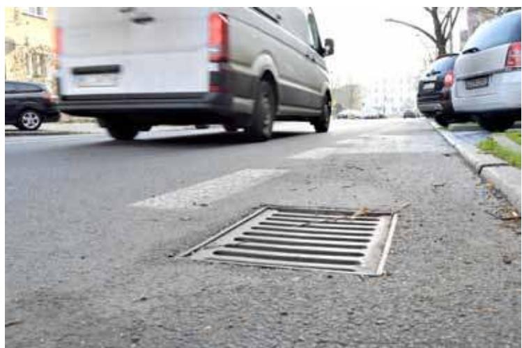
Od początku roku MPGK wybudowało 3,2 km sieci kanalizacji
