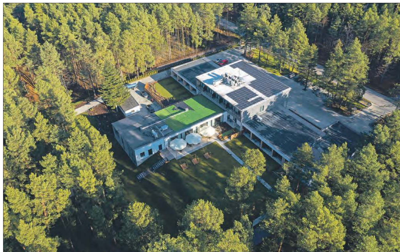
Budynek hotelu Szumy Park w Sułcu po termomodernizacji
