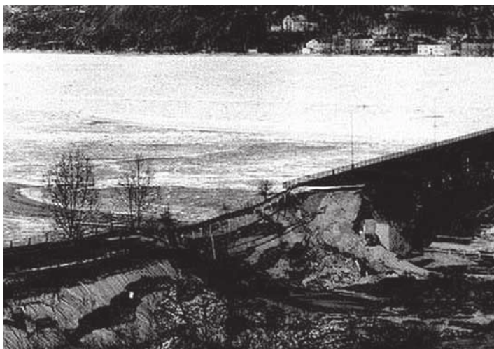
Zarwany most drogowo-kolejowy na Wiśle (1982)
