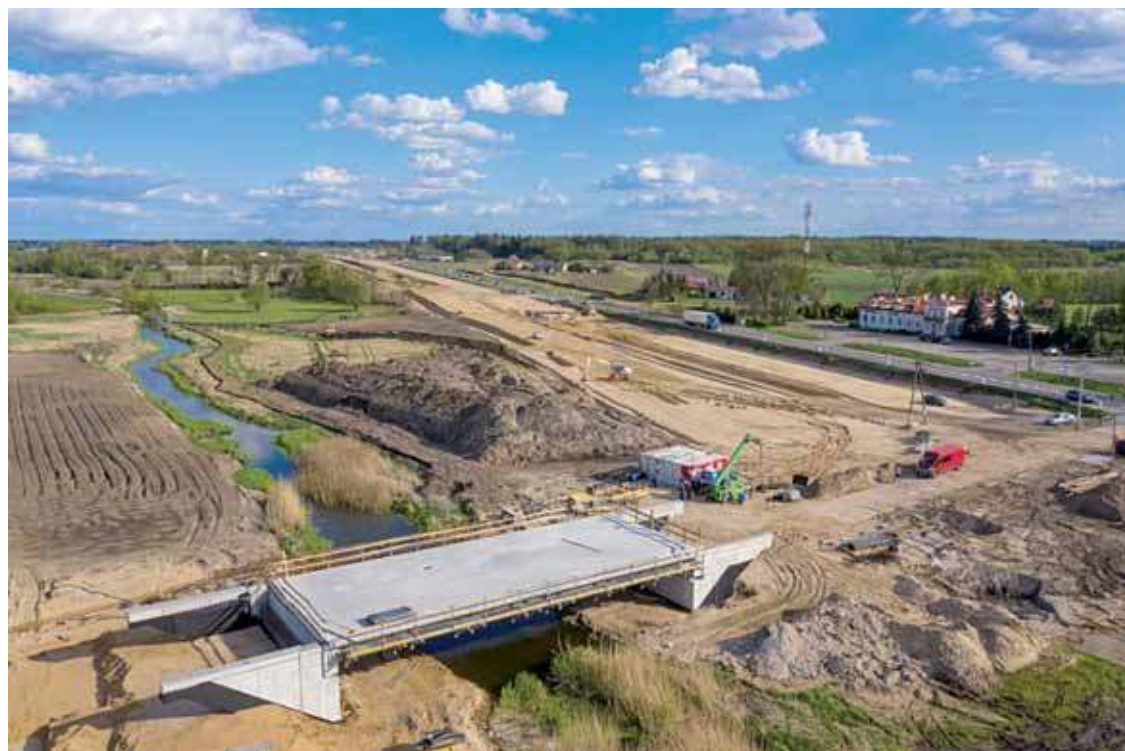
Fragment budowy S7 w pobliżu zjazdu w Dłużewie
