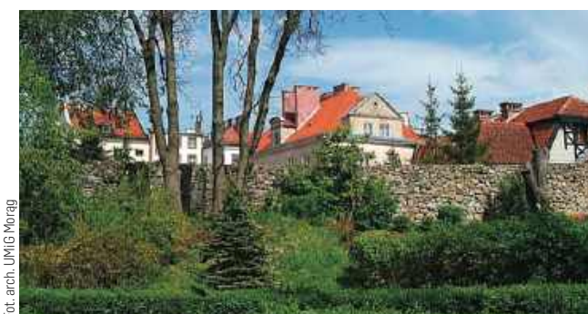
Średniowieczne mury obronne w Morągu i uszkodzony fragment
