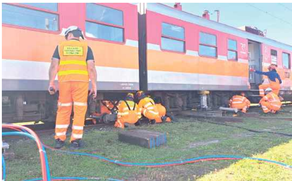
Ratownicy kolejowi pracowali przy usuwaniu skutków symulowanego wykolejenia pociągu
