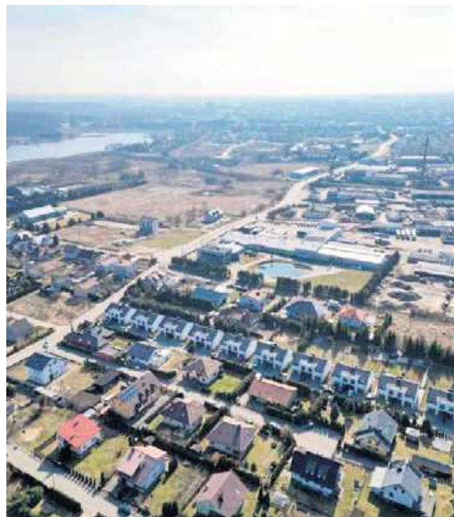
Mieszkańcy osiedla nie chcą, aby powstał tu zakład
