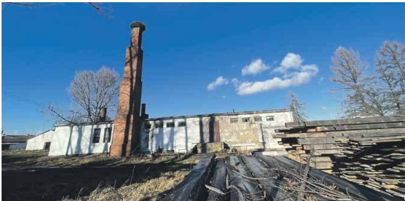
Czy stara kotłownia stanie się biogazownią?
