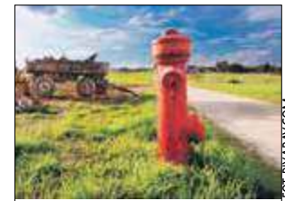
Na terenie gminy Międzyrzec Podlaski już kilukrotnie w ostatnim czasie doszło do nielegalnego poboru wody z hydrantów
