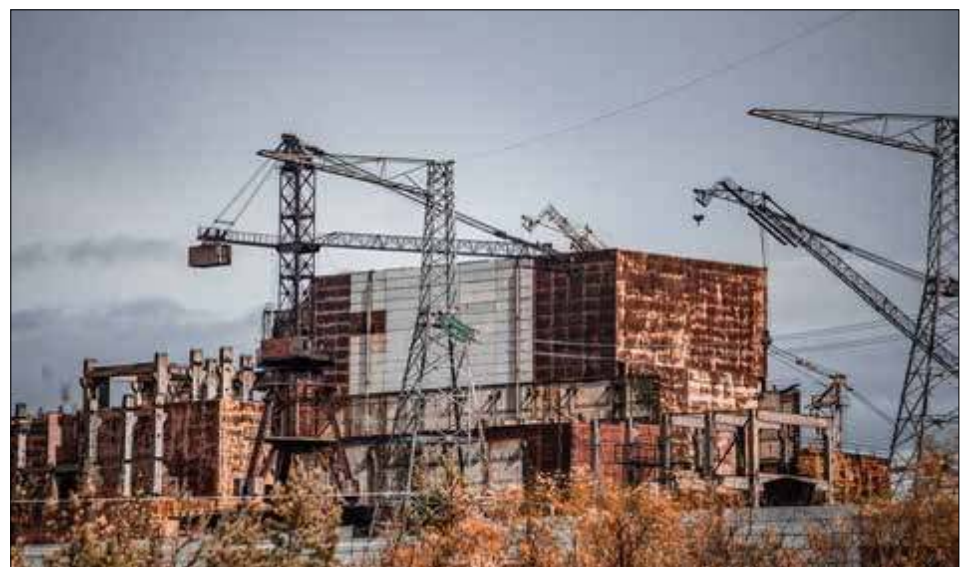
Blok nr 5 czarnobylskiej elektrowni. Nie został nigdy ukończony. Inwestycję przerwała katastrofa w bloku 4
