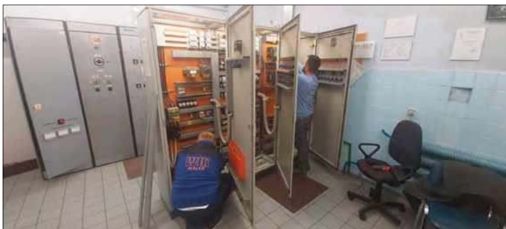
Prace trwają, ale stacja już działa.
