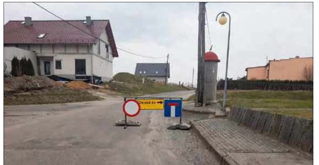
W Oleszce postępują prace związane z budową kanalizacji sanitarnej.
