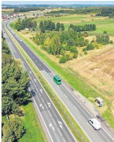
Roboty przy DK91 mają potrwać 18 miesięcy
