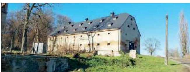
■ Zakończono remont dachu spichlerza w Sławikowie FOT. UG RUDNIK
