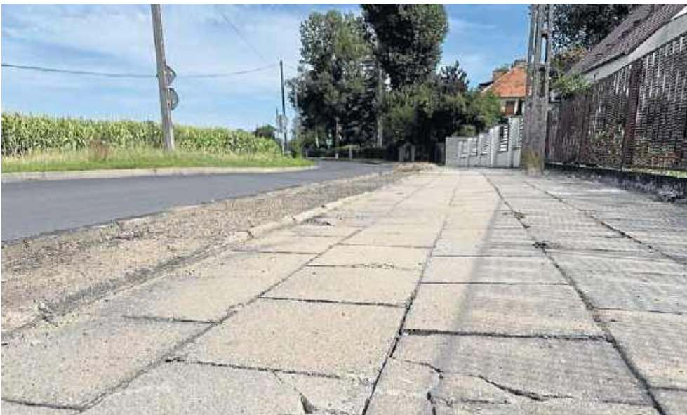
Remont chodnika na ul. Berdychowskiej w Wągrowcu
