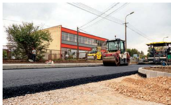
... i w trakcie
