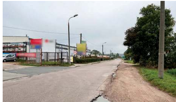
Ulica Śmiecińska przed remontem
