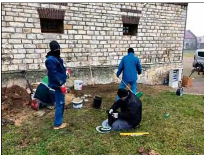
Prace montażowe wykonali mieszkańcy.
