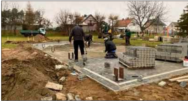
Pierwszy etap prac to wykonanie podłoża z kostki betonowej. Na niej zostanie postawiona drewniana wiata.
