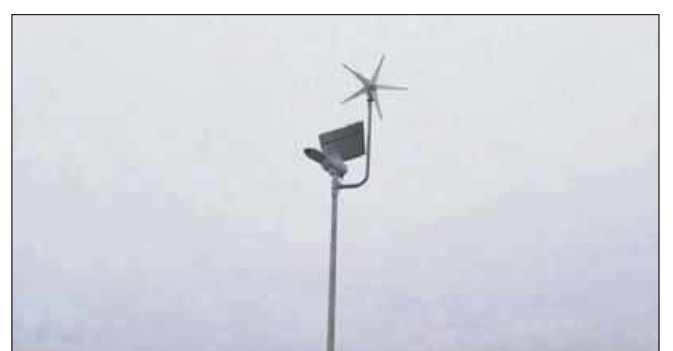
W Komornikach zakończono montaż dwóch lamp hybrydowych.
