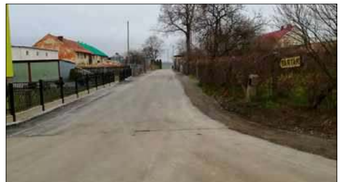
Wyremontowana droga w Nowym Budzie liczy 210 m.
