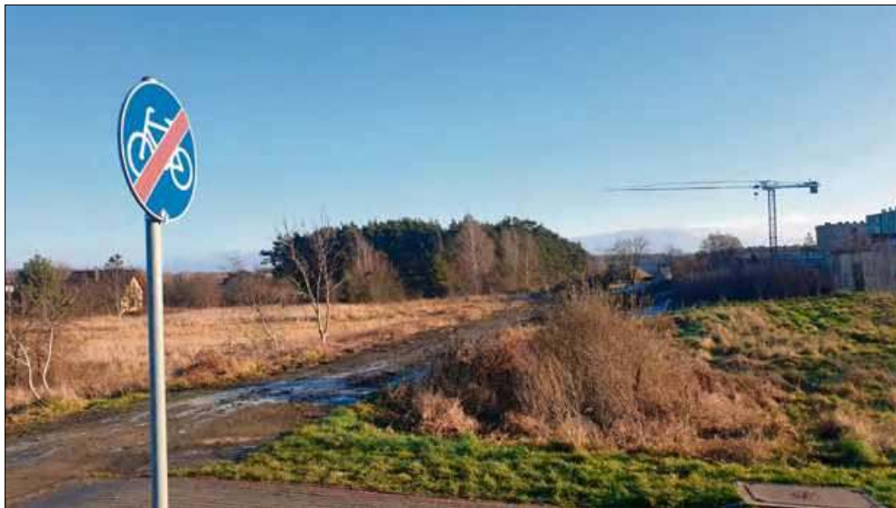
Budowa ciągu pieszo-rowerowego łączącego Halę Widowiskowo-Sportową im. Władysława Piechoty w Krapkowicach z osiedlem XXX-lecia po starym śladzie kolejowym kosztować ma 1 009 500 zł.
