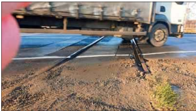
Obluzowana szyna podnosi się w górę, gdy samochód przejeżdża przez przejazd.
