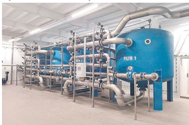
Stacja Uzdatniania Wody w Piasecznie po gruntownym remoncie
