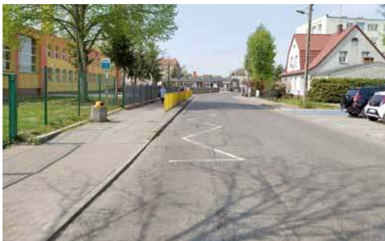
Ulica Żeromskiego jest jednym z ważniejszych odcinków w mieście, więc jest następna w kolejce do całonocnej przebudowy
